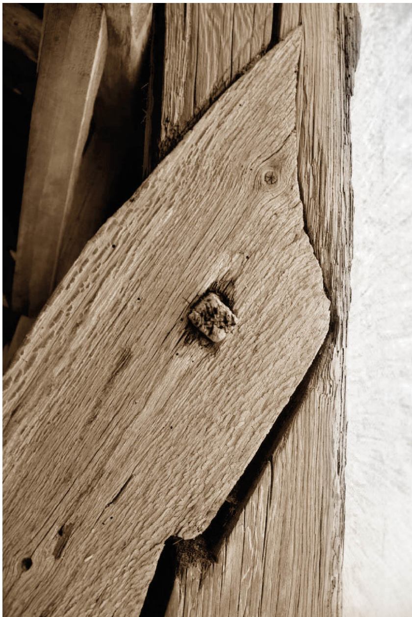
1. Kamień Pomorski, Katedra pw. św. Jana Chrzciciela. Wieszba dachowa, wschodnie wiązary nad nawą środkową. Połączenie miecza stopowego z krokwią na nakładkę zaczepową. Fot. U. Schaaf, 2021.
