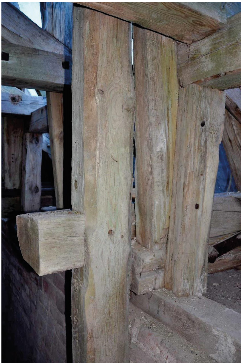
2. Kamień Pomorski, Katedra pw. św. Jana Chrzciciela. Więżba dachowa, wschodnie więzary nad nawą środkową. Wtórne dodanie elementów w więzarze nr 22: belki kulawkowej oraz miecza stopowego.
