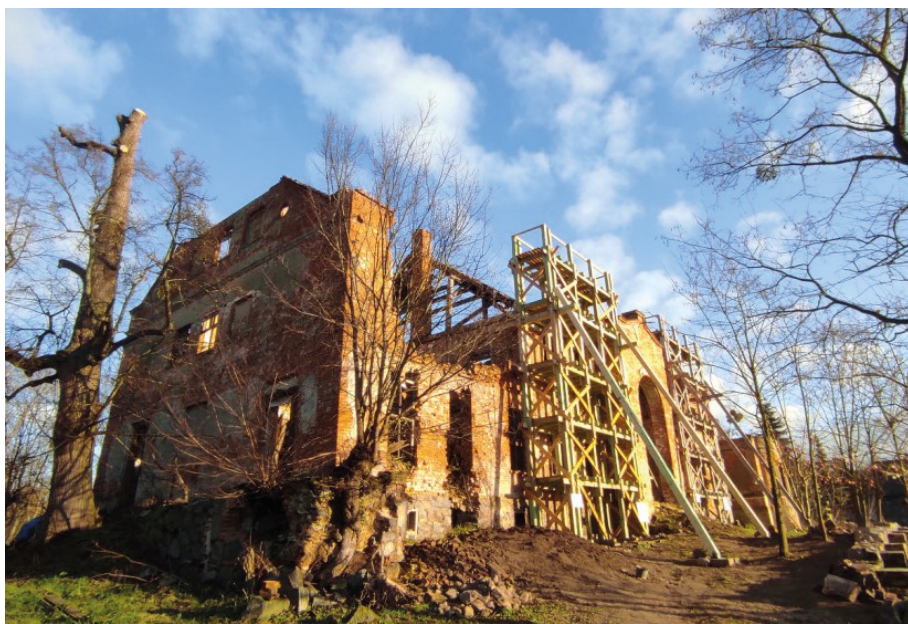
7. Pałac po zabezpieczeniu murów centralnej partii rusztowaniami. Fot. Cz. Skwirzyński.
