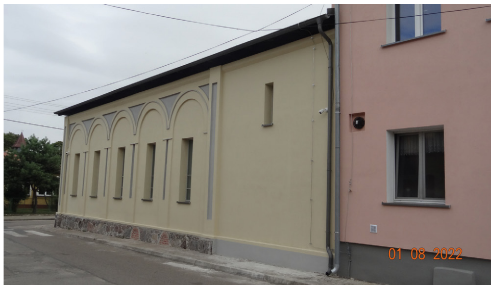
7. Budynek dawnej synagogi po wykonaniu prac remontowo-adaptacyjnych, elewacja przy ul. Pocztowej. Fot. A. Musiał-Gąsiorowska, 2022.
