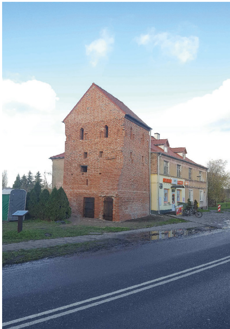
5. Baszta Więzienna, elewacja zachodnia i południowa po remoncie. Fot. A. Musiał-Gąsiorowska.
