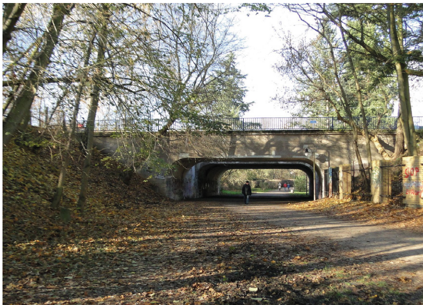
1. Wiadukt kolejowo-drogowy, Szczecin ul. Fałata, stan przed rozbiórką 2016 r. Fot. A. Hamberg-Federowicz.
