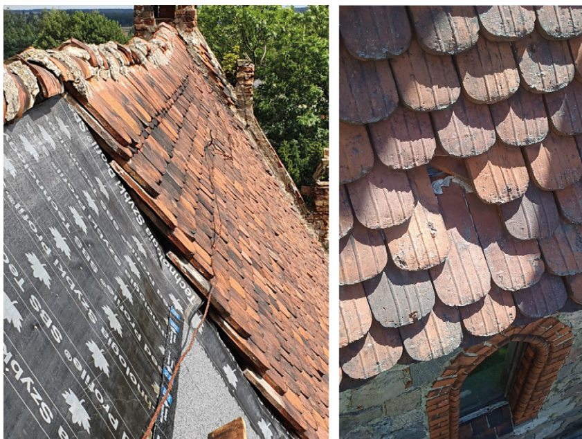
2. Prace przy rozbiórce pokrycia dachowego oraz widok pokrycia przed pracami. Fot. P. Radecki.
