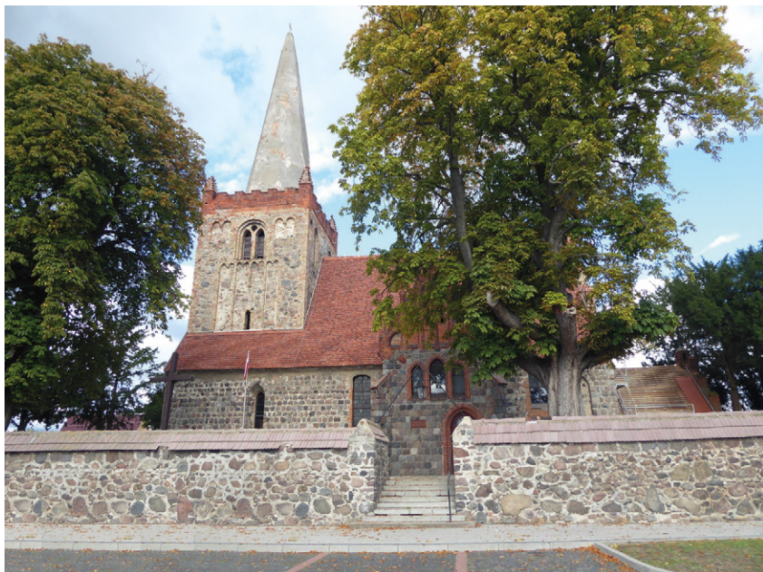
1. Kościół w Witnicy, widok od strony południowej po wykonaniu prac. Fot. M. Sokołowska.
