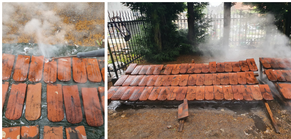
4. Mycie dachówek parą wodną pod ciśnieniem. Fot. P. Radecki
