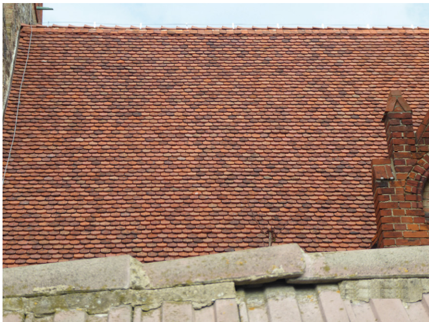
7. Widok na południową połąć dachu po wykonaniu prac. Fot. M. Sokołowska.
