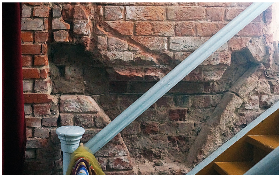
8. Odkrywki od strony wnętrza sali dawnego kościoła cysterek w Koszalinie na ścianie zachodniej (po stronie północnej od wejścia) – wykucie na założenie sklepienia empory zachodniej i na ścianie północnej – fragment skutego sklepienia empory (druga wnęka od wschodu). Fot. A. Piwek, 2021.
