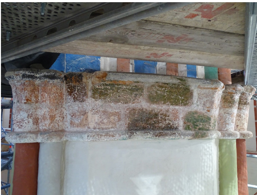
8. Filar w nawie głównej po odstonięciu przemalowań na glazurowanych kształtkach. Fot. I. Nałęcka-Czerniawska, 2022.
