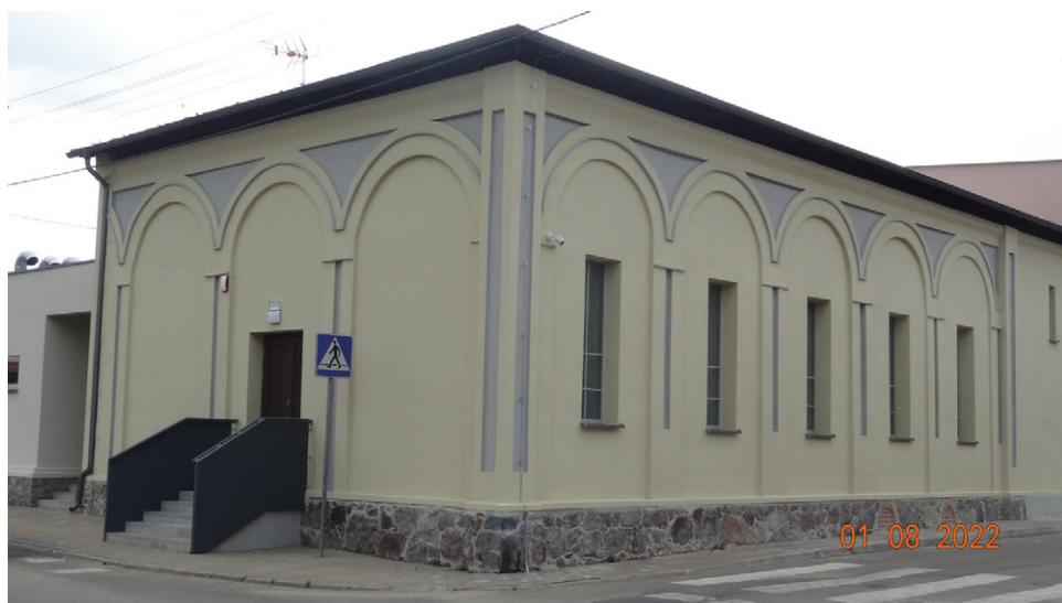
8. Budynek dawnej synagogi po wykonaniu prac remontowo-adaptacyjnych, elewacja północna i zachodnia. Fot. A. Musiał-Gąsiorowska, 2022.
