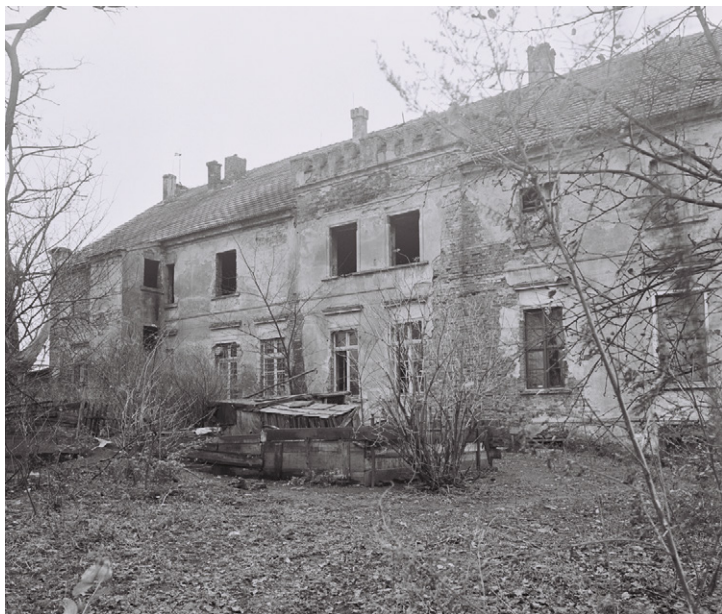
4. Elewacja północna pałacu w 1978 r., z: Katalog dworów i pałaców...
