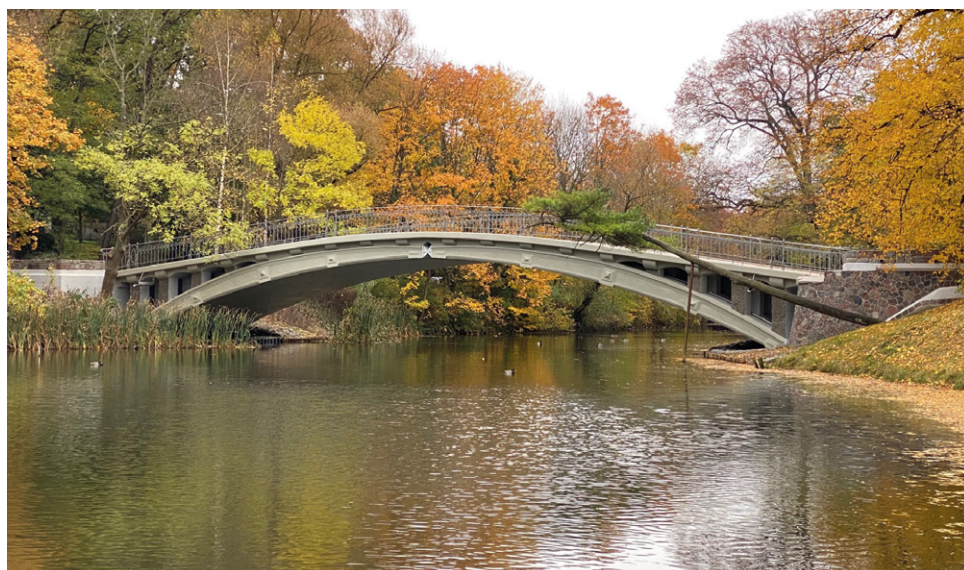
6. Szczecin, most nad jez. Rusałka w Parku Kasprowicza po zakończeniu prac remontowo-konserwatorskich, 2022 r. Fot. Z. Paszkowski.
