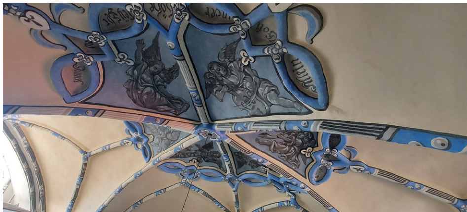
2. Zrekonstruowane pierwsze sklepienie w przęśle wschodnim nawy głównej zgodnie z zachowanymi XVII-wiecznymi odkrywkami. Fot. I. Nałęczka-Czerniawska, 2021.
