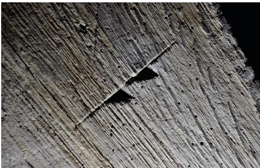
4. Kamień Pomorski, Katedra pw. św. Jana Chrzciciela. Więźba dachowa nad skrzyżowaniem naw. Znak montażowy w formie trójkątków przy kresce w ramie stolcowej. Fot. U. Schaaf, 2021.
