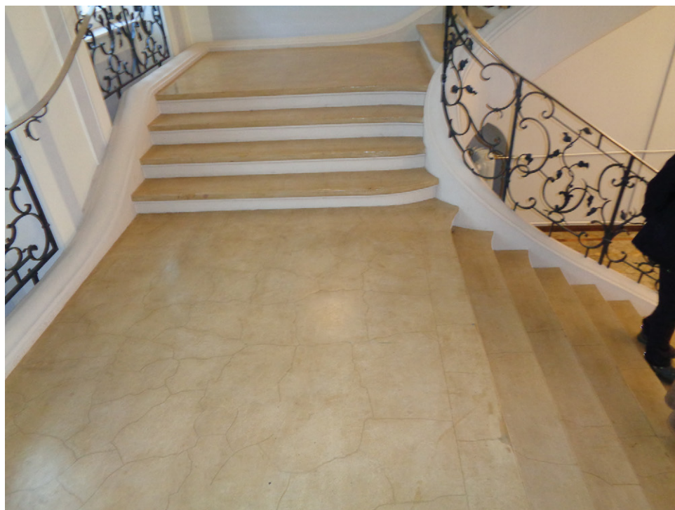
7. Urząd Miasta Szczecin, klatka schodowa w skrzydle bocznym, okładzina stopni i podestów po pracach konserwatorskich, 2022 r. Fot. A. Hamberg-Federowicz.
