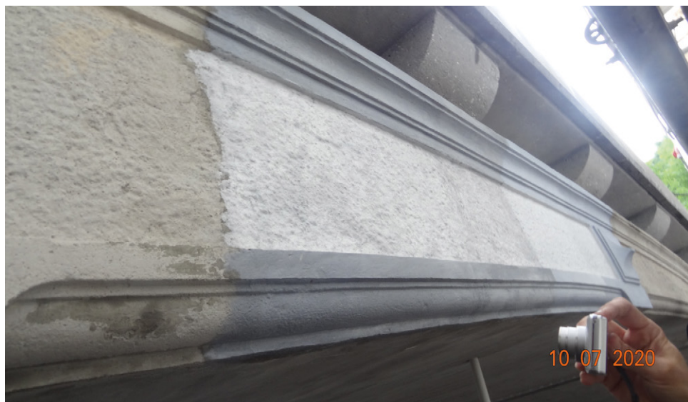
5. Szczecin, most nad jez. Rusałka w Parku Kasprowicza, stan w trakcie prac remontowo-konserwatorskich – analiza kolorystyczna powłoki scalającej, 2020 r. Fot. A. Hamberg-Federowicz.
