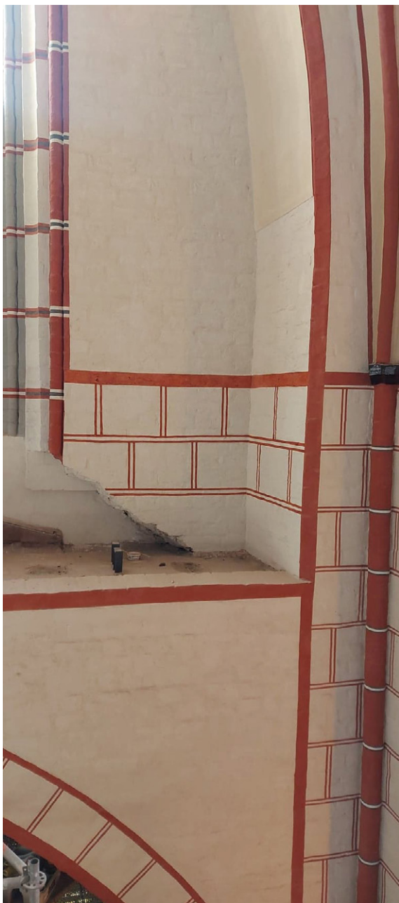
1. Kwadrowanie gotyckie, w górnej partii świątyni, pas fryzowy, nawra południowa w części zachodniej, prawdopodobnie podkreślała pierwotną wysokość świątyni halowej. Fot. I. Nałęcka-Czerniawska, 2021.
