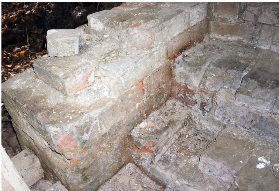
9. Odkopany fragment klatki schodowej przylegający do południowo-zachodniego naroża dawnego prezbiterium. Fot. M. Jedlikowska, 2021.
