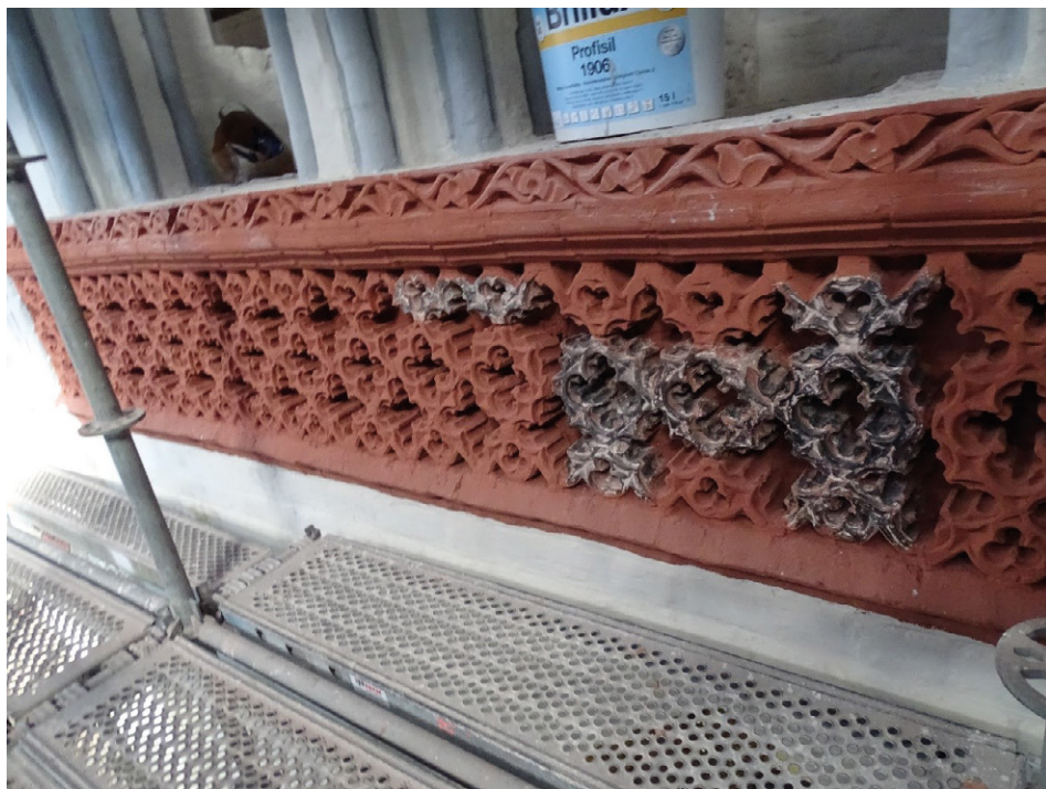
4. Fragment fryzu maswerkowego z oryginalną czarną glazurą na powierzchni kształtki. Fot. I. Nałęcka-Czerniawska, 2020.
