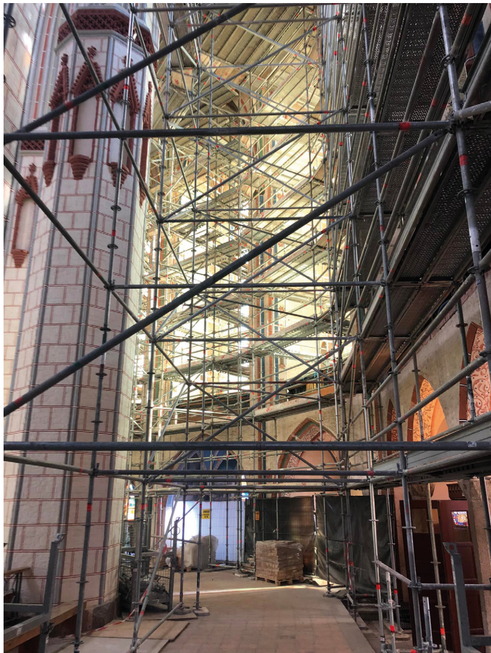
13. Wnętrze kolegiaty podczas prac – widok rusztowań od strony chóru muzycznego, w tle widok na obejście prezbiterium. Fot. M. Lewandowski, 2022.
