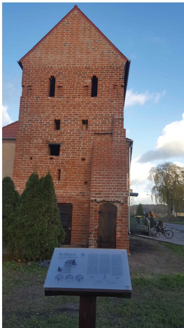
4. Baszta Więzienna, elewacja zachodnia po remoncie. Fot. A. Musiał-Gąsiorowska.
