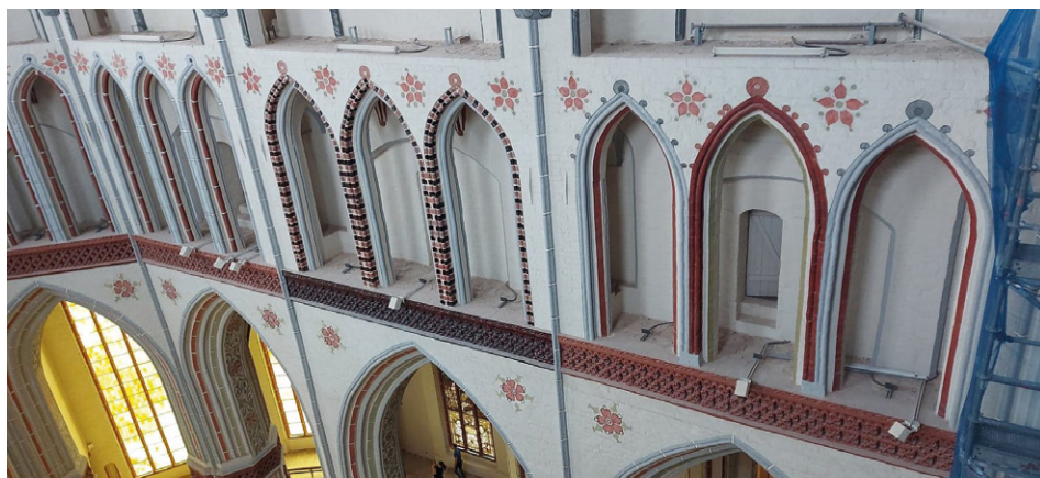
5. Widok na galerię triforyjną po zakończeniu prac konserwatorskich – arkady po prawej stronie malowane w kolorze szarości i zieleni, na szczytach zdobione czołgankami, po lewej stronie kształtki glazurowane tworzące obramienie dla arkad. Fot. I. Nałęcka-Czerniawska, 2020.
