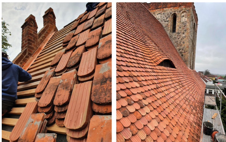
6. Z lewej: wykonanie opierzenia i układanie dachówki. Z prawej: połacie północna – widok na wole oko. Fot. P. Radecki.
