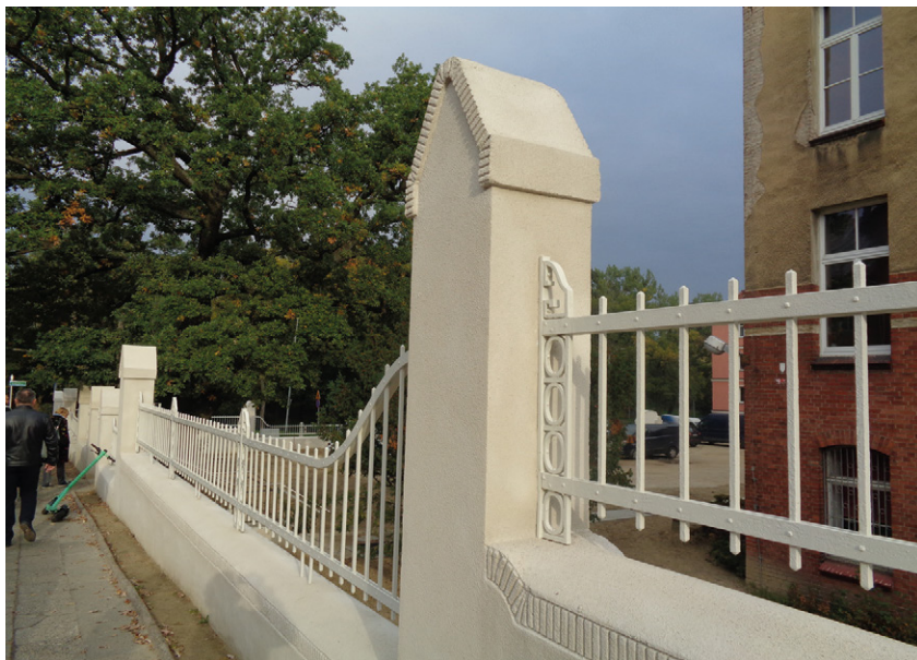
3. Szczecin, ul. Jagiellońska, ogrodzenie szkoły po pracach konserwatorskich, 2022 r. Fot. A. Hamberg-Federowicz.
