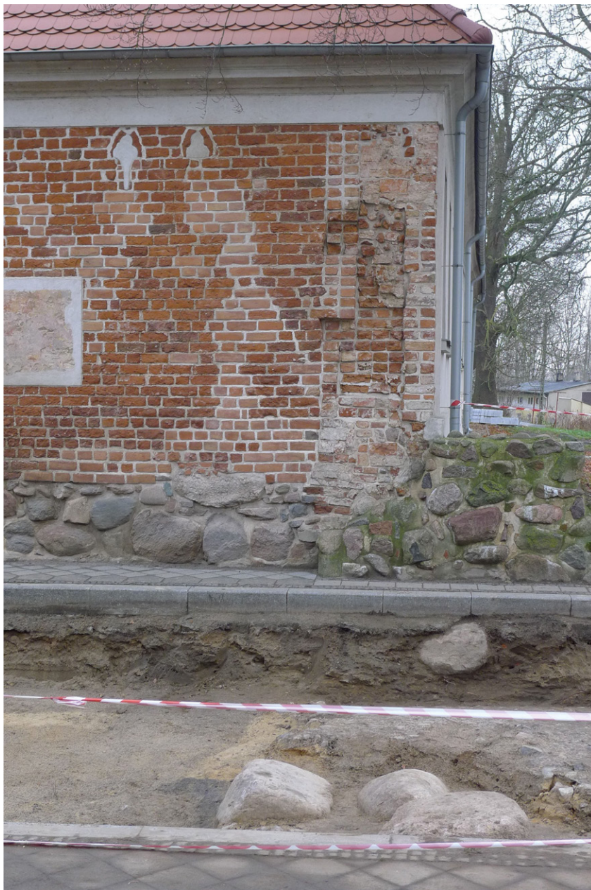
9. Ślad po frontowej ścianie bramy widoczny na zachowanym fragmencie bramy wykorzystanym wtórnie jako boczna ściana Kurii Dziekana. Na pierwszym planie widoczne fundamentowanie ściany frontowej bramy.
