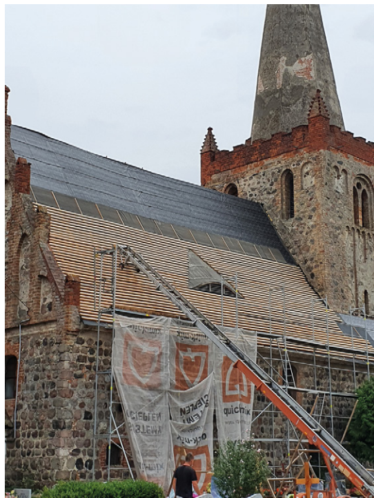
5. Wykonanie izolacji z papy oraz układanie nowych lat. Fot. P. Radecki.
