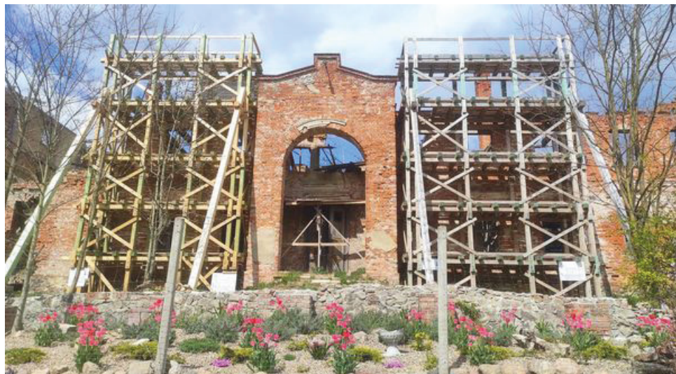
8. Fasada po zabezpieczeniu murów rusztowaniami. Stan z 2022 r. Fot. ze zbiorów właścicielki pałacu.
