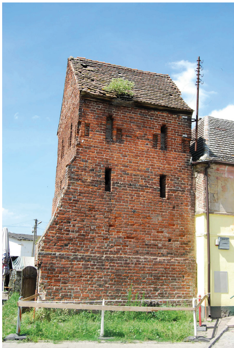
3. Baszta Więzienna, elewacja południowa, stan przed remontem. Fot. z archiwum WUOZ w Szczecinie.
