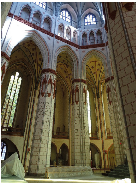
3. Widok na prezbiterium po zakończeniu prac konserwatorskich. Fot. I. Nałęczka-Czerniawska, 2021.
