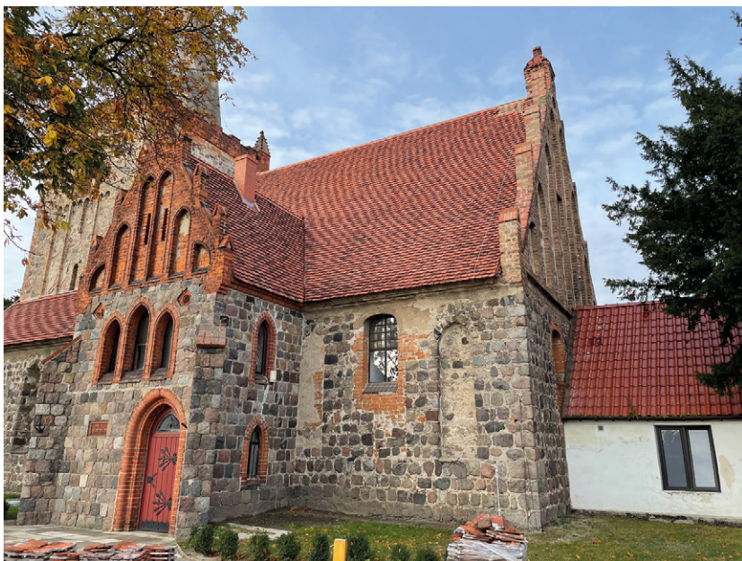
8. Widok na kościół od strony południowej po wykonaniu prac. Fot. P. Radecki.
