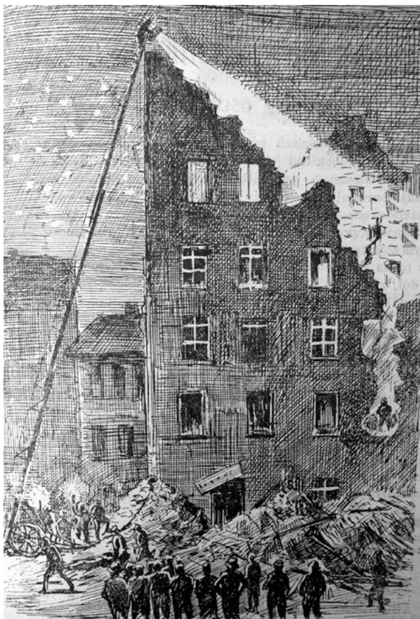
Oświetlenie terenu akcji w porze nocnej
