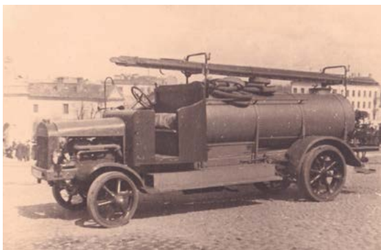
Autopogotowie Austro-Fiat, druga połowa lat 30. z zabudowaniem zbiornika o znacznej pojemnościach Źródło: Centralne Muzeum Pożarnictwa w Mysłowicach.
