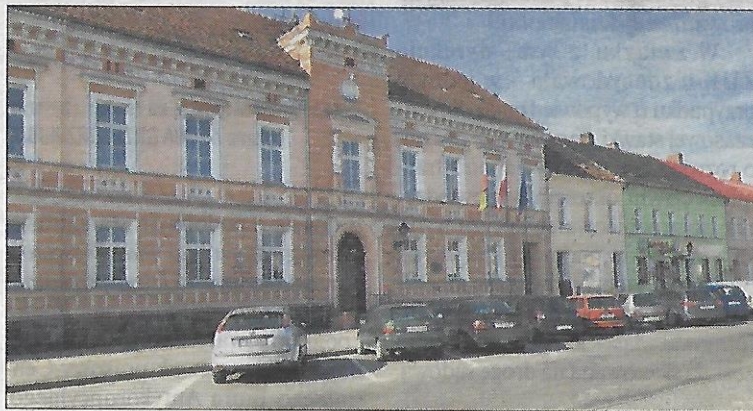
Na bojanowskim rynku jest około kilkadziesiąt miejsc parkingowych, w tym 12 pod budynkiem urzędu miejskiego
