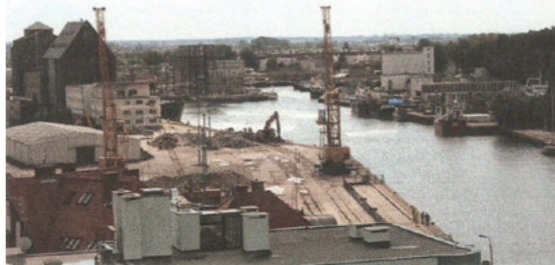
Rys. 90. Widok na nabrzeża portu handlowego w Kołobrzegu. Fot. K. Ratajczyk.
