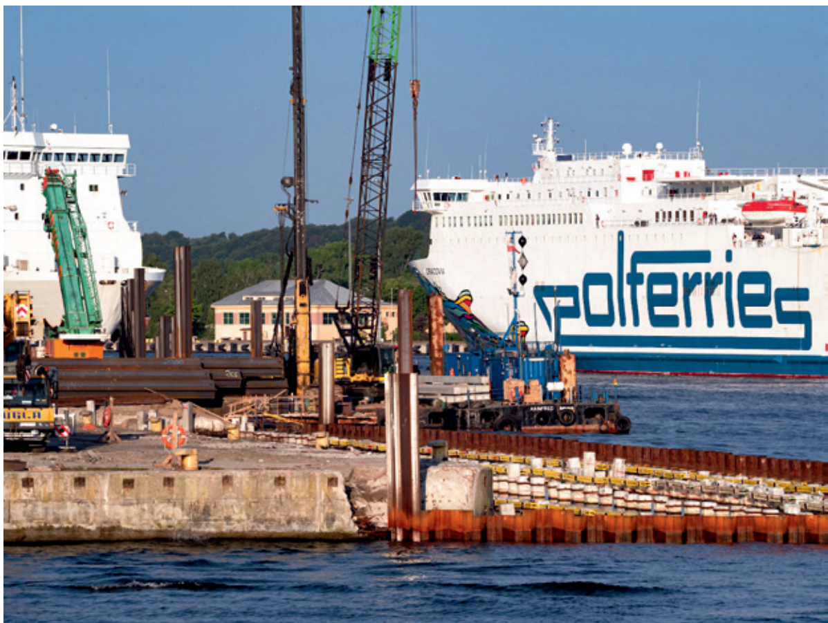
Prace modernizacyjne w porcie Świnoujście. Fot. W. Mileńko.
