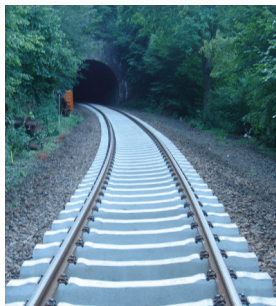
der Gleisbau railway construction budowa torów kolejowych f железнодорожное строительство n
