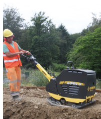
die Vibrationsplatte umg die Rüttelplatte (vibrating-) plate compactor wibrator płytowy m виброплита f
