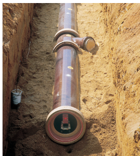
der Kanalbau sewer construction budowa kanałów f строительство канализации n
