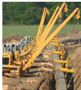
der Rohrleitungsbau pipeline construction budowa rurociągów f строительство трубопровода n
