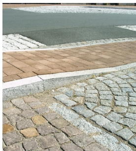
der Straßenbau road construction budowa dróg f дорожное строительство n
