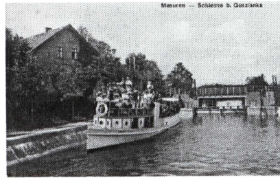
Guschienen / Guszianka, Blick auf Schleuse und Brücke
